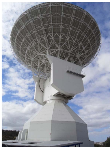
Fig. 1 New Norcia 35 m terminal.
